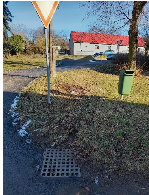
č.4 Bývalý kanálek ze žlabovek
