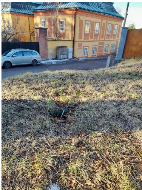
č.5 Přepad potrubí SZ části hráze
